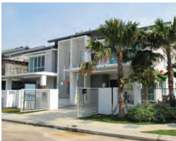
d'Laman Greenville, Bukit Tinggi
