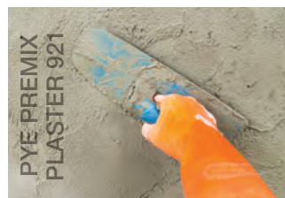
Level and smoothen external surface with steel trowel. 第一步用抹子拉平外墙表面。
