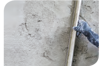
Level the surface with a long wooden float. 用长木抹子均匀涂布在施工面上。
