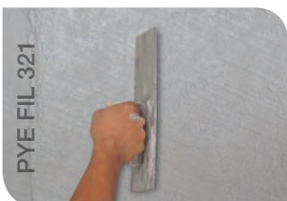
Level internal surface with base coat. 第一层用抹子拉平内墙表面。
